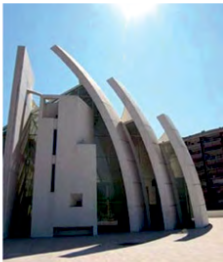
Ослепительную белизну церкви Dives in Misericordia в Риме обеспечивают наночастицы диоксида титана
